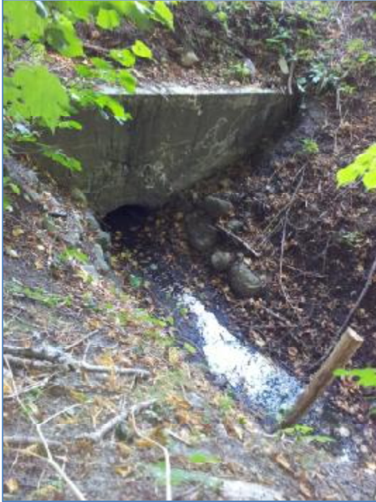
Indløb under Oddenvej st. 1166
