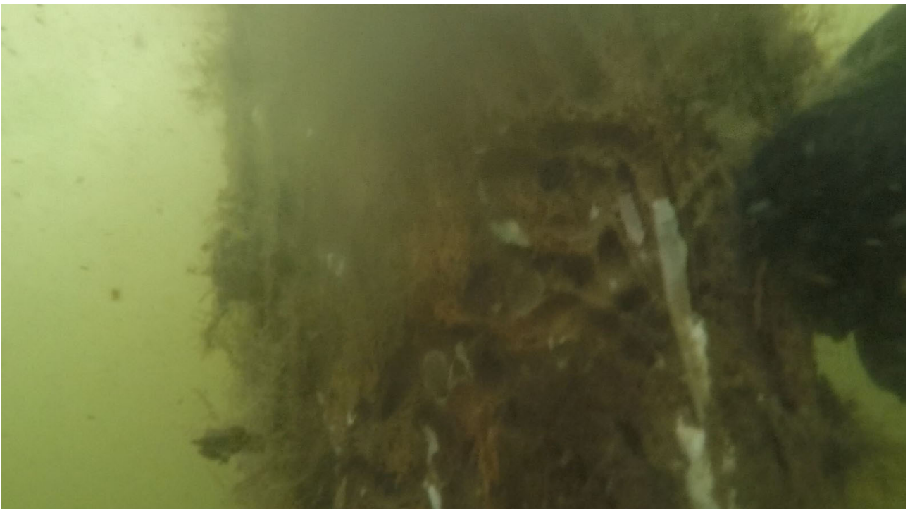
Figur 7 - Nabopæl til ovenstående. Ligeledes helt spist af pæleorm.
