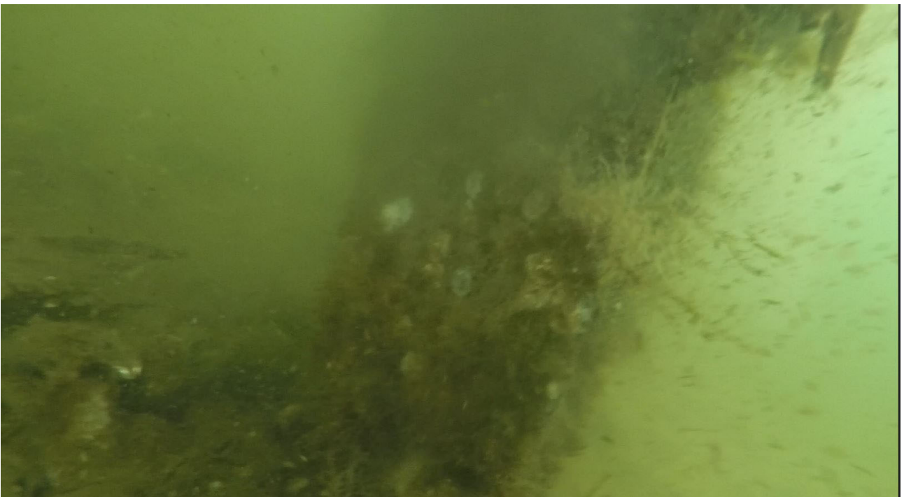
Figur 9 - Pæl ved plads 654 er helt væk af pæleorm
