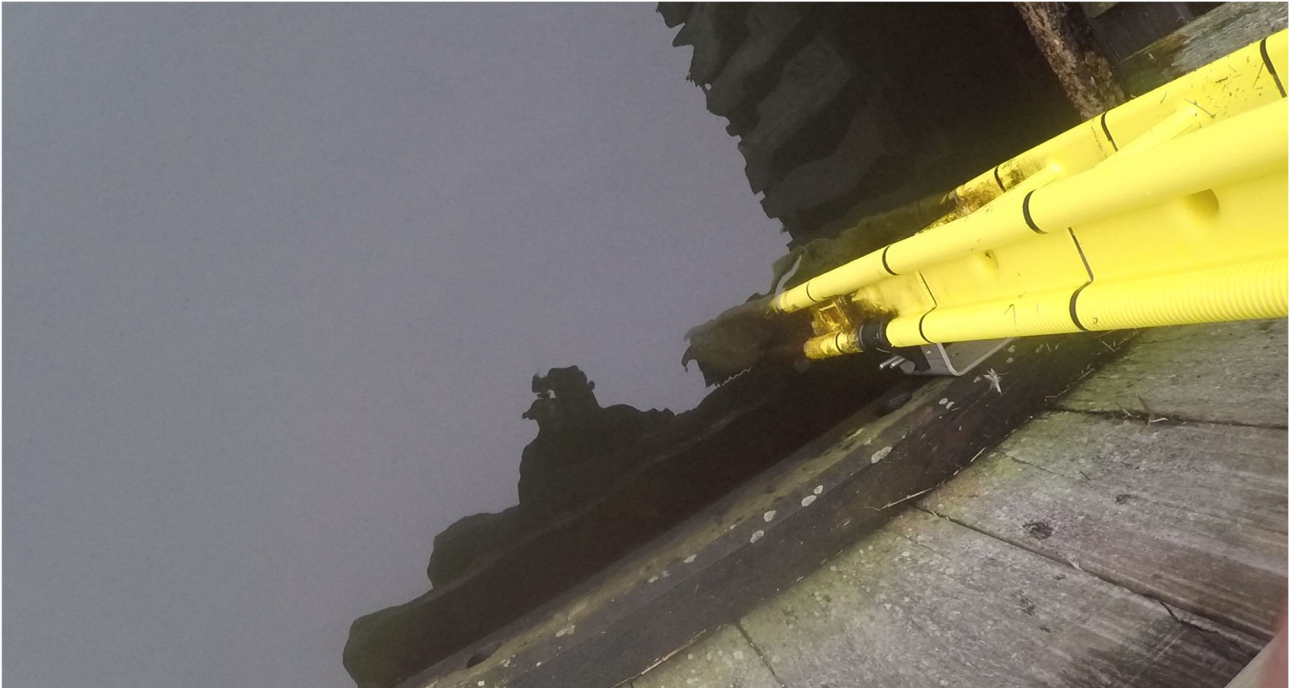
Figur 3 - Redningsstige nr. 2 fra land på bro 7 mangler skruer.
