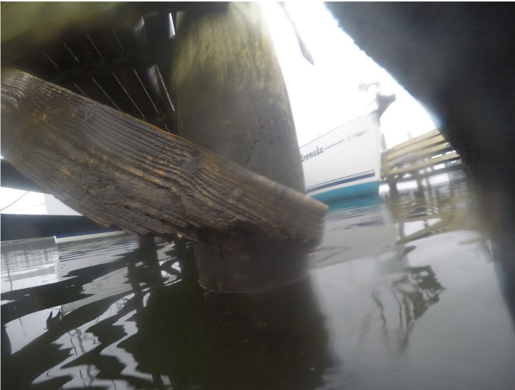
Figur 5 - Kryds på stikmole (på Bro 7) er råddent i bunden.
