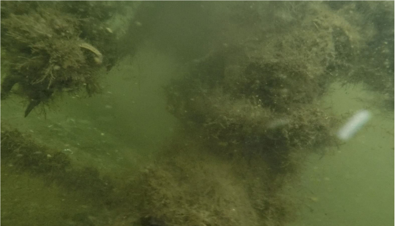
Figur 6 - Pæle ved plads 631 helt spist af pæleorm. Rører kun minimalt bunden.
