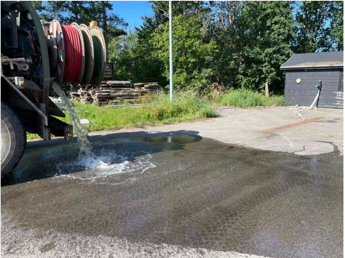
Figur 2.2: Foto som viser, at der hældes vand på terræn for at følge hvordan vandet spredes i terræn og til kloakker
