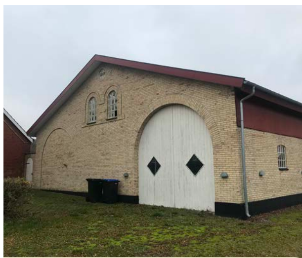
På Stålhøjvej i Asnæs har bygherren besluttet at beholde den gamle gård fra 1900-1923 og lave den om til 17 moderne lejligheder. Det betyder, at vi både sparer på jordens ressourcer, men også at områdets kulturhistorie bliver bevaret.
